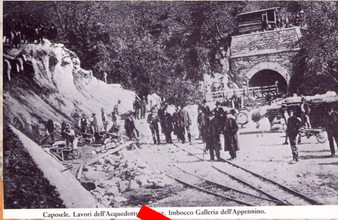
Caposele. Lavori dell'Acquedotto Pugliese. Imbocco Galleria dell'Appennino.
