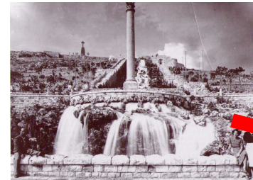
Santa Maria di Leuca, Acquedotto Pugliese. Cliché Terni, 1917.
